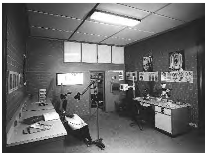
Fig. 9. Roma, Musei Vaticani, Gabinetto Ricerche Scientifiche (1970-1980). Sala per la microscopia, indagini radiografiche e riprese fotografiche. Si nota la presenza del microscopio binoculare "Tessovar" e del tubo radiografico "Gilardoni" utilizzato anche per l'esecuzione delle radioscopie. Il vano è stato totalmente isolato mediante il rivestimento delle pareti con la lamina in piombo. Sulla parete è ben evidente la foto del volto della Madonna della Pietà di Michelangelo, il cui restauro è stato svolto in collaborazione con il Gabinetto Ricerche Scientifiche.
