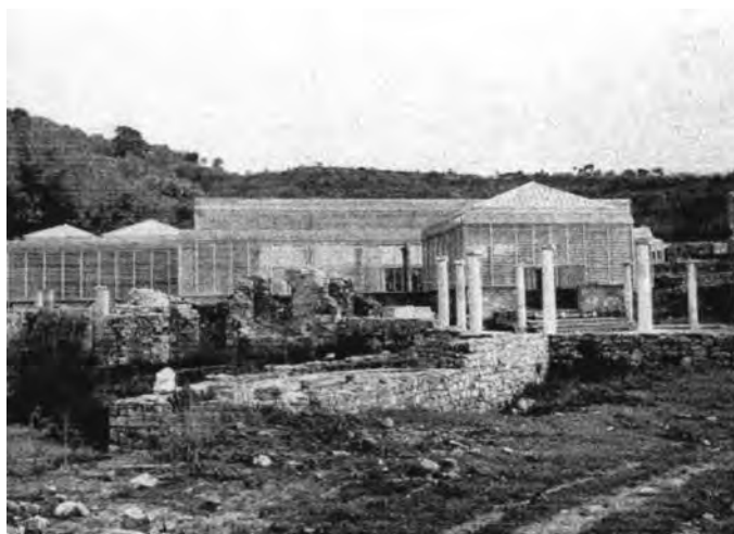
Fig. 1. Piazza Armerina, Villa Romana detta “del Casale”: uno dei peristili dopo le anastilosi di inizio Novecento, prima della copertura in plexiglas. Si noti il vecchio corpo dell' Antiquarium in muratura (Foto: Istituto Archeologico Germanico di Roma).
