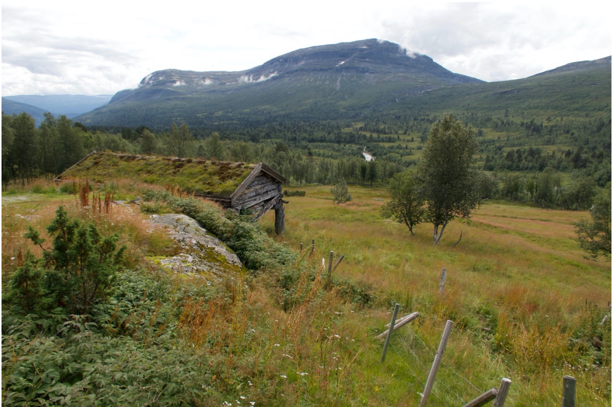
Figur 20. Setervollen sett fra hyttetomta i overkant og nedover, med fjellet Borga i bakgrunnen. Låven, som delvis er skjult bak en knaus, ble restaurert tidlig på 1980-tallet. Som det delvis vises på bildet så siger torva noe nedover, og det er behov for å få lagt den om igjen. Foto: Geir Gaarder.
