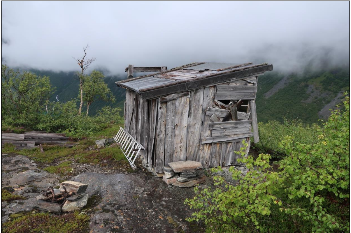
Figur 13 Heishuset. Det står enno, men taket er mangelfullt halde ved like og om ikkje noko vert gjort snarleg så vil nok dette vere tapt for godt i løpet av få år. Foto: Geir Gaarder
