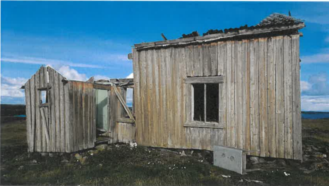
Eksisterende fasade mot øst
