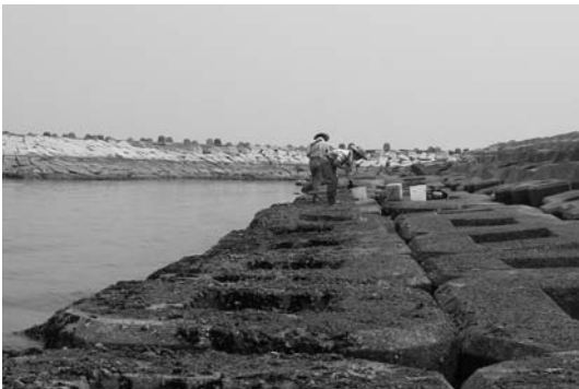
図4. ヘッドランドNo. 6の突堤部側面 (2007. 2. 11撮影).
