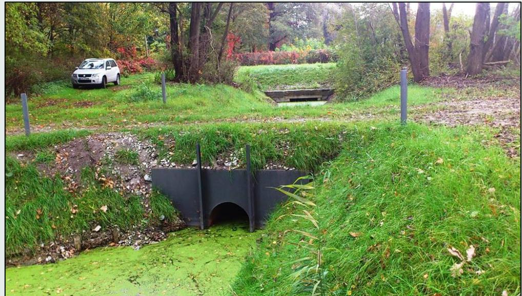
Mögliche Ausführungsvariante für ein regulierbares Staubauwerk – Stahlrohr mit angeschweißtem Staurahmen und Überführungsmöglichkeit (Foto: Tesch)
