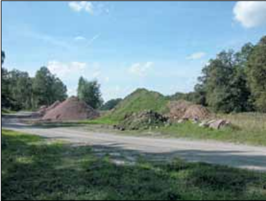
Abb. 1: Der Zustand des Flächennaturdenkmals „Binnendüne Aken“ im Oktober 2010 mit Baustoffhalden im östlichen Teil. Foto: P. Göricke.
