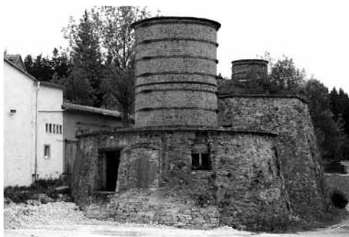
Abb.: histor. Kalkofen am Kalkwerk Hermsdorf
