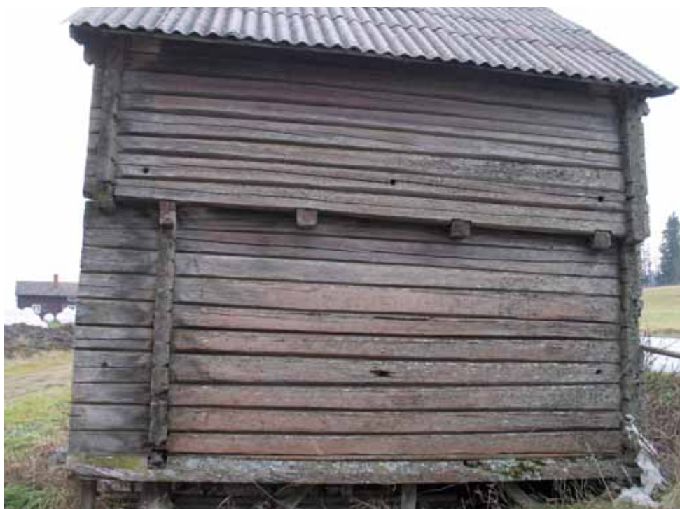
Bild 5. På den utskjutande bottenstocken på denna gamla timmerbyggnad växer vedorangelav. Ladans nedre del är blekt rödfärgad av Trentepohlia -alger, medan man på de översta stockarna närmast taket kan se spår av gammal rödfärgning. Jämtland. Foto: Fredrik Jonsson
