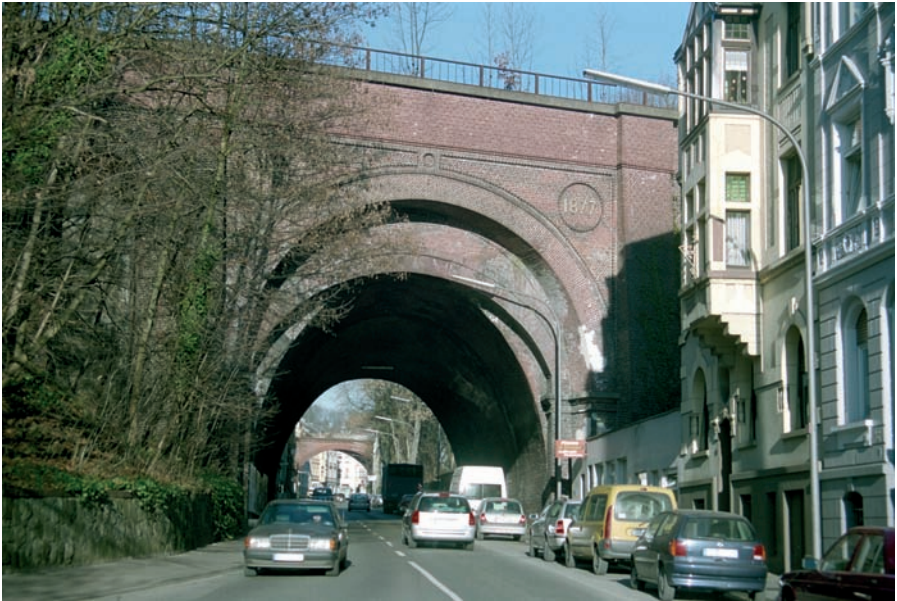
Abb. 13: Eisenbahnunterführung Schönebecker Straße
