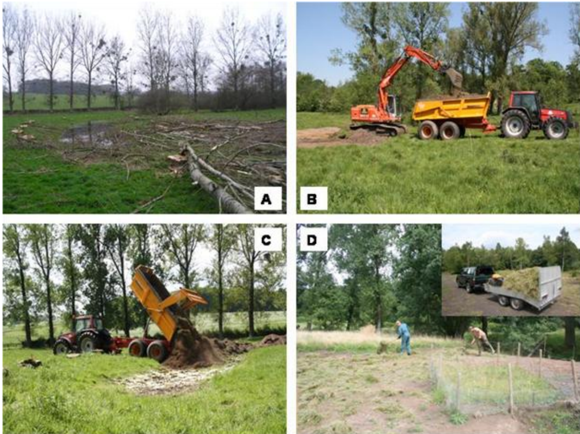
Figuur 6.1 Maatregelen die in 2008 zijn genomen door NM om de zinkflora in het zinkreservaat te herstellen. A, plaatselijke kap van populieren in maart 2008; B+C, plaggen van de bovenste 10-20 cm bodem waarbij de af te voeren bodem verwerkt is binnen het terrein zelf; D, aanbrengen van maaisel uit Plombière op de geplagde delen van het terrein.
