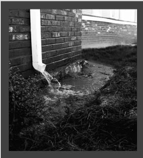
El exceso de agua alrededor de la casa agrieta y daña sus bases y las paredes del sótano.
