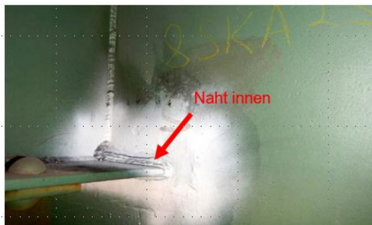
Abb. 3: Prüfstelle im Hohlkasten
