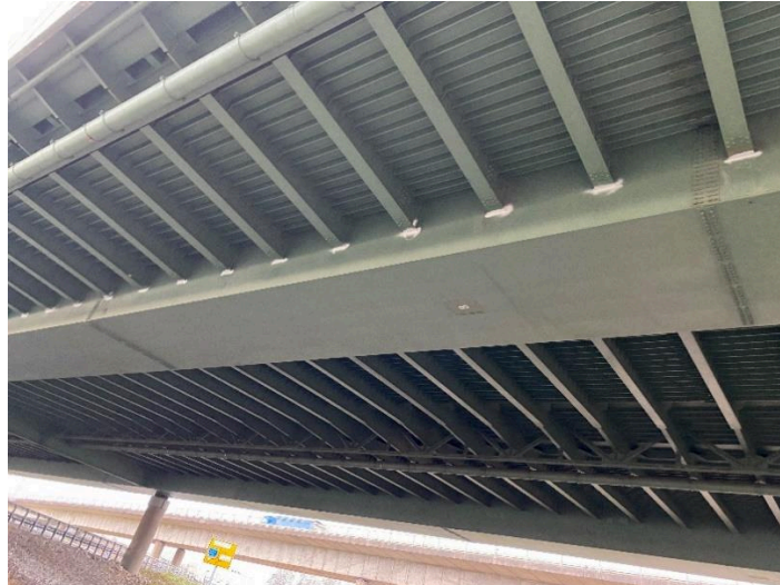
Abb. 1: Hohlkasten mit Kragarmen und Kehlnaht am T-Stoß.
