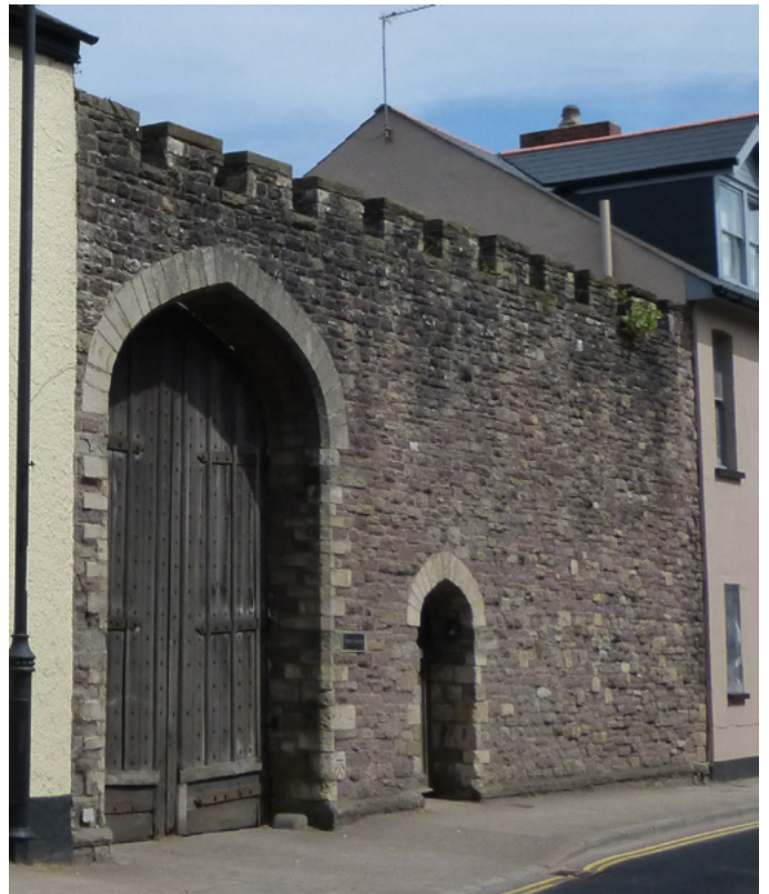
Ffotograff 16: Rhan o wal carreg Pennant â bylchfuriau, gan ddangos deunydd adeiladu lleol a chyfrannu at gymeriad milwrol rhan ganolog y Stryd Fawr
