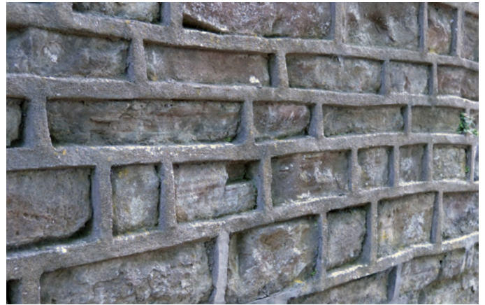
Ffotograff 26: Gwaith pwyntio rhuban eithafol yn Lôn y Castell, sy'n niweidiol i gyflwr y garreg
