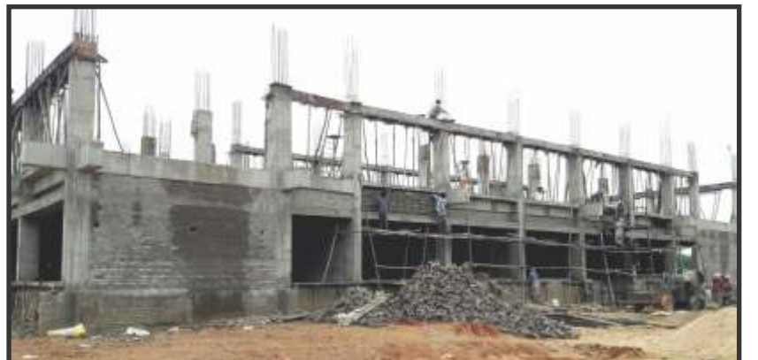
सी.आर.सी. नेल्लूर के भवन का निर्माण
