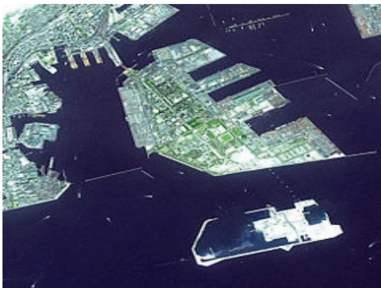
(工事中の神戸空港)
