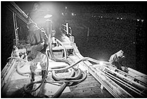
写真6 運搬船へののりの移送
