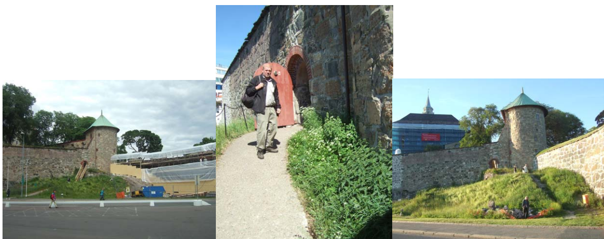
Figur 11 Lokalteten for tunhunderot ved inngangen til Vestre krutt-tårn, Akershus. Til høyre og venstre under og rett etter restaurering av festningsmuren sommeren 2010. I midten Odd Stabbe-torp betrakter en blanding av tunhunderot (plante inntil mur ca midt i bildet), skvallerkål og brennesle.
