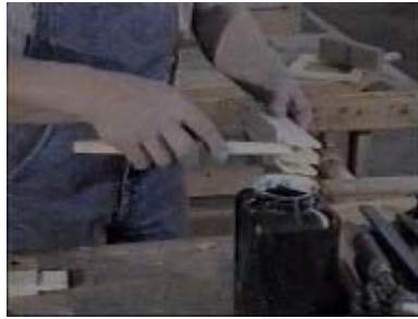
24. ábra. Csaprések ragasztóval való bekenése 24
