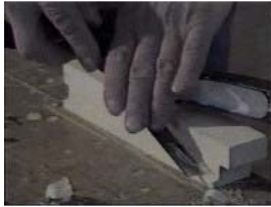
10. ábra. Élek kitisztítása 10
