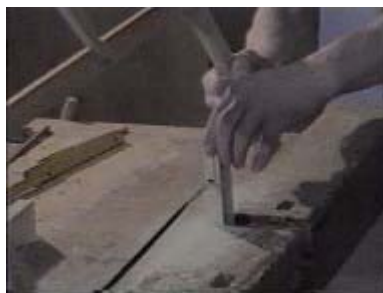
21. ábra. Csaprés kifűrészelése sarokkivágó fűrésszel 21
