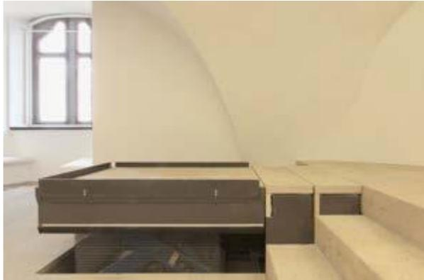
Integration einer Hubplattform in historischen Treppenlauf in der Albrechtsburg zu Meißen. Um den Klemmschutz zu sichern, wurde die Hubplattform mit einer umlaufenden Sensorleiste ausgestattet, welche bei Berührung die Mechanik abschaltet. Die Bedienung kann selbstbestimmt erfolgen (Raum und Bau GmbH)
