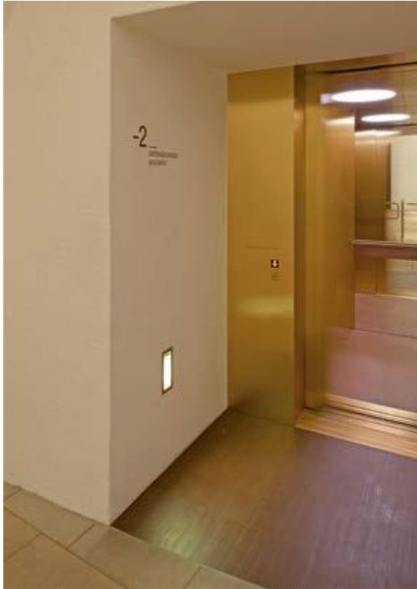
Integration eines Besucheraufzuges in die komplexe Geometrie einer mittelalterlichen Burgranlage. Der neue Bodenbelag vor dem Aufzug kann taktil erkannt werden – Albrechtsburg zu Meißen (DD1 Architekten)
