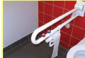
Der Notrufschalter am WC ist in den Stützgriffen integriert. Er muss eindeutig erkennbar, taktil erfassbar und leicht auszulösen sein:
