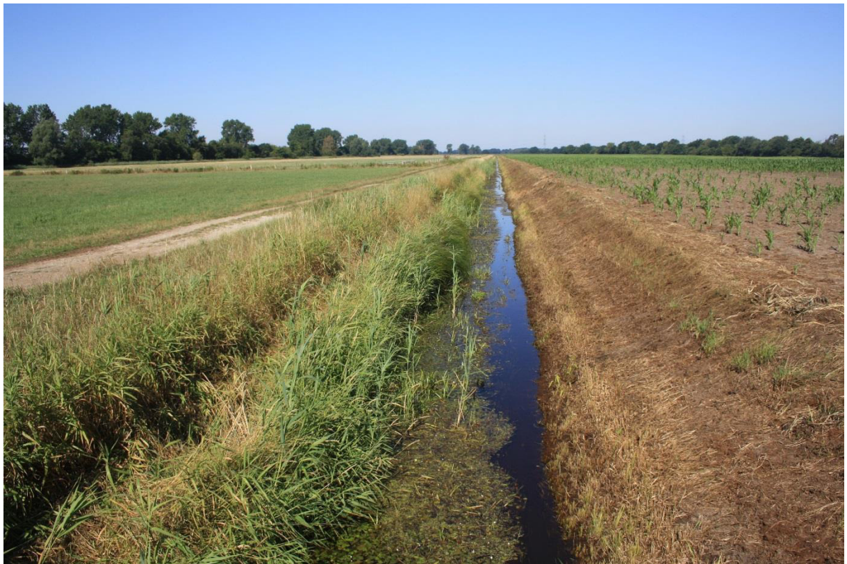
Halbseitige Mahd von Böschung und Sohle des Nordbachs im Juli 2018 (westlich Rehburg)
