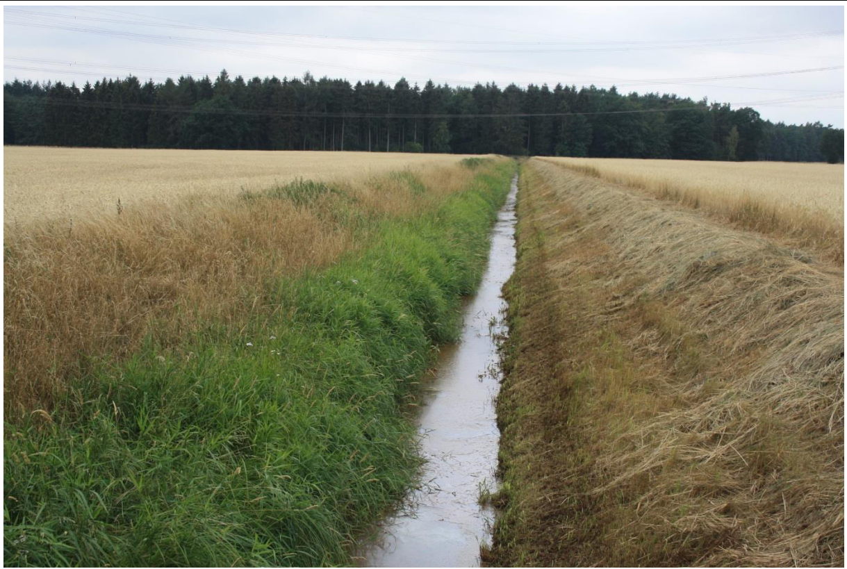
Halbseitige Mahd der Böschungen Anfang Juli 2018; Blickrichtung von der Mündung in den Meerbach nach Westen
