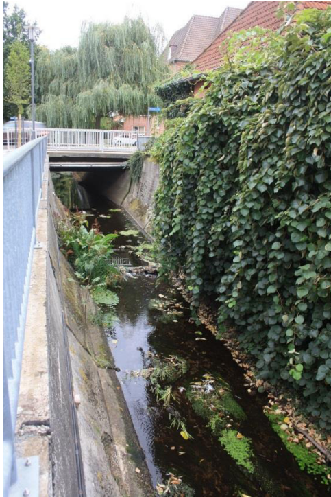
Beton-U-Profil mit fehlenden Uferstreifen in Rehburg
