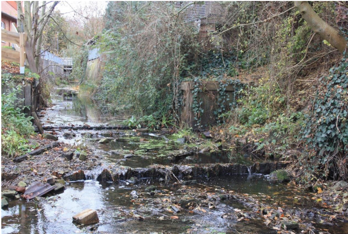
Die beiden kleinen Sohlabstürze in der Ortslage Rehburg bei km 24+900
