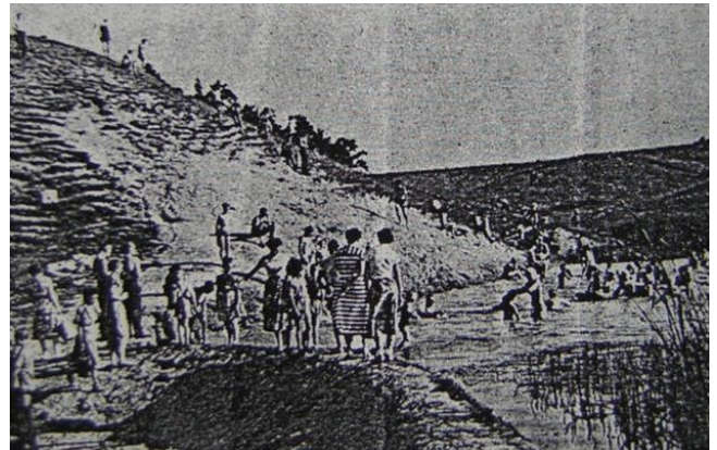
Foto 60: Staudamm des oberen Teiches in den 1930er Jahren vor der Beschädigung durch militärisches Befahren (Kap. 5.1.2.1; Quelle: HiAZ vom 23.07.1973).
