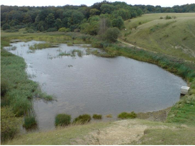
Foto 84: Ablassen des oberen Teiches (30.08.2011)
