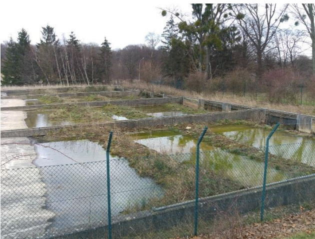
Foto 191: Becken im Folgejahr nach Abschluss der Umbaumaßnahmen (19.02.2019)
