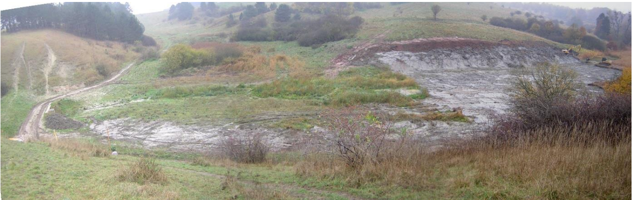
Foto 70: Entschlammung des oberen Teiches (2. Bauabschnitt, 02.11.2008)
