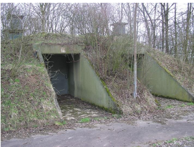
Foto 180: ehemalige Munitionsbunker im Nordwesten des Plangebiets (06.04.2006)
