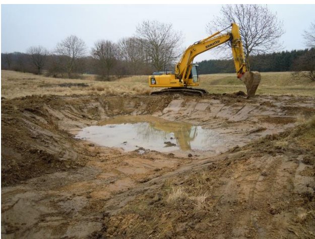
Foto 168: Vergrößerung Tränke im Südosten des Plangebiets (14.03.2012)
