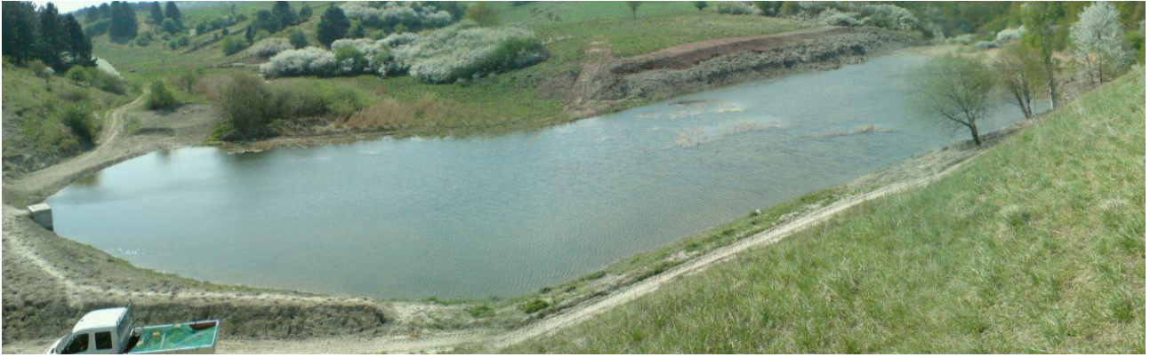
Foto 73: erste Befüllung des oberen Giesener Teiches nach der Entschlammung (16.04.2009)
