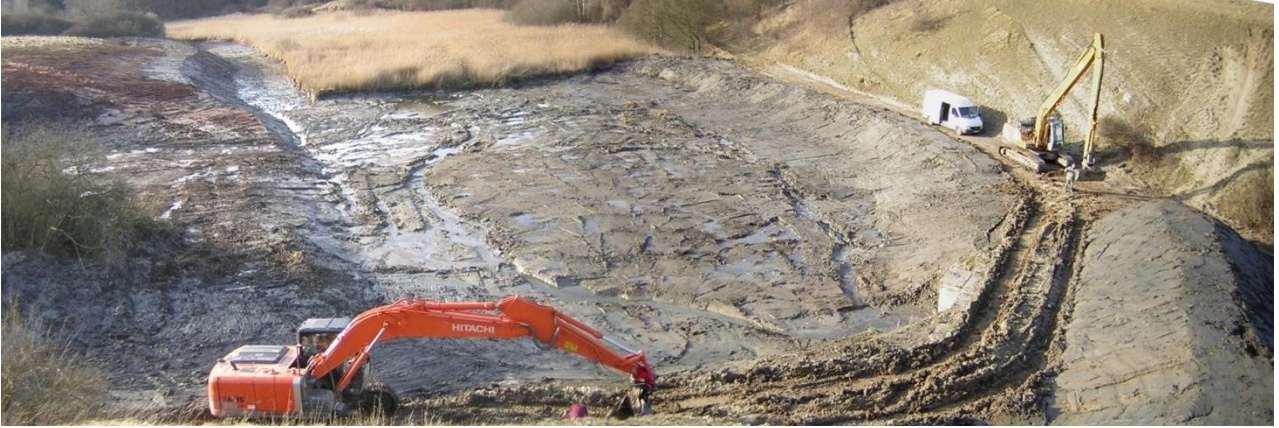
Foto 66 und 67: Entschlammung des oberen Giesener Teiches (1. Bauabschnitt, 25.02.2008)
