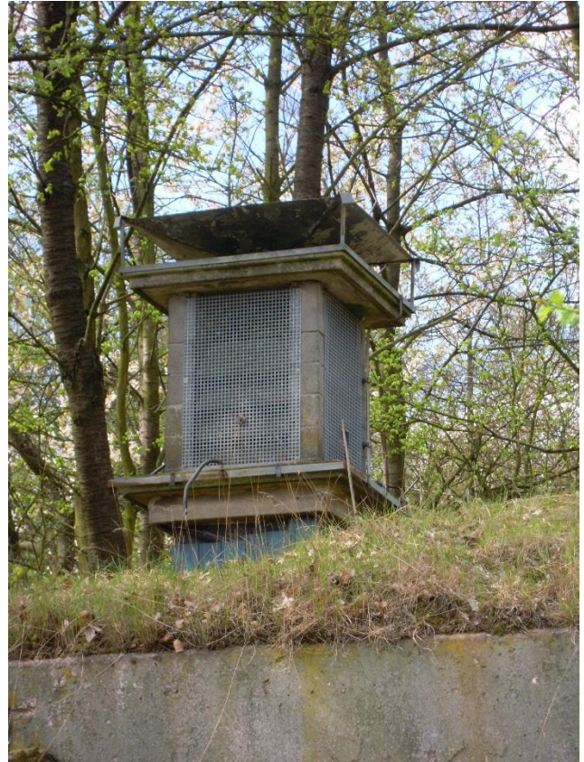
Foto 183: Regensammeltrichter zur Erhöhung Luftfeuchte in Quartierbunkern (23.04.2012)
