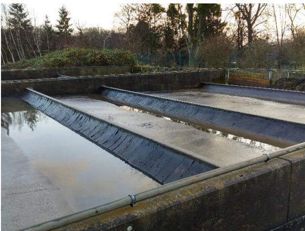
Foto 185: Einbau Betonstaustufen in die zwei mittleren Becken (08.12.2017)
