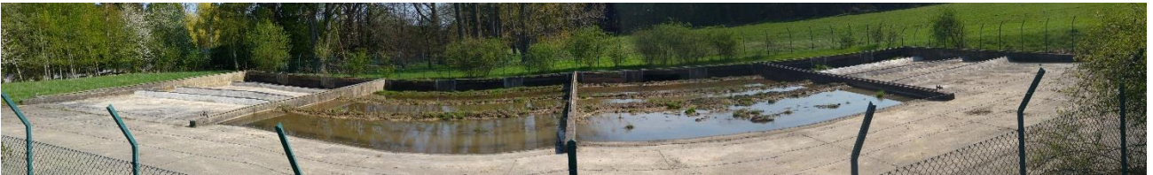
Foto 189: Gefüllte mittlere Becken und Umbau der zwei randlichen Becken (20.04.2018)
