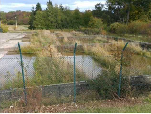
Foto 193: Becken im Folgejahr nach Abschluss der Umbaumaßnahmen (11.10.2019)
