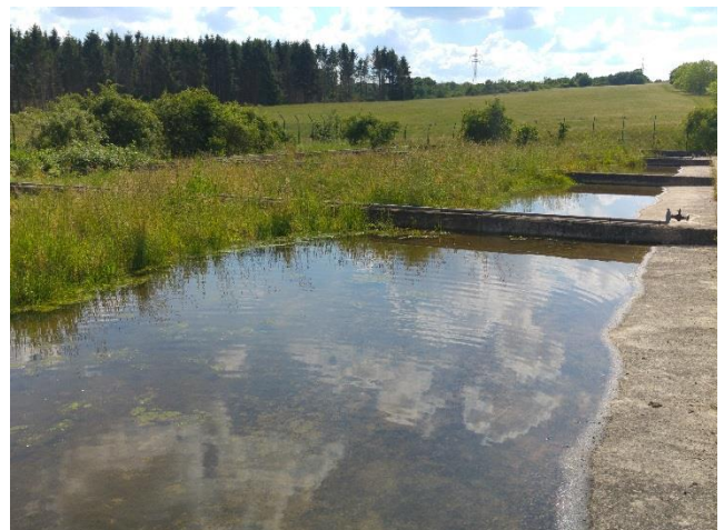
Foto 192: Becken im Folgejahr nach Abschluss der Umbaumaßnahmen (17.06.2019)
