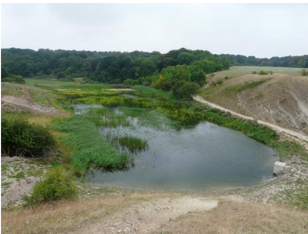
Foto 74: oberer Teich im ersten Sommer nach der Entschlammung (11.08.2009)
