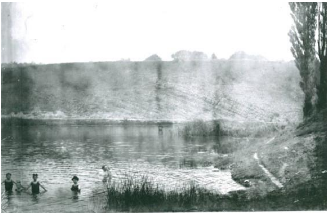
Foto 59: oberer Giesener Teich um 1910 (LAUFER 2010, Quelle: StA Hi 953, Nr. 1160).
