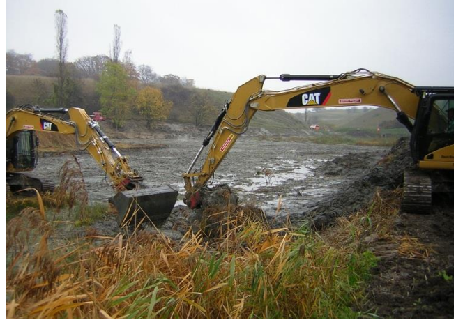
Foto 69: Entschlammung des oberen Giesener Teiches (2. Bauabschnitt, 05.11.2008)
