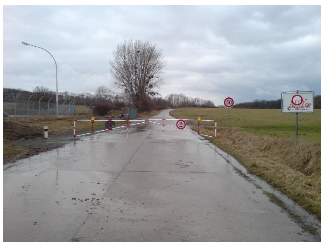
Foto 197: überbreite ehemalige Panzerstraße vor dem Umbau (11.03.2009)
