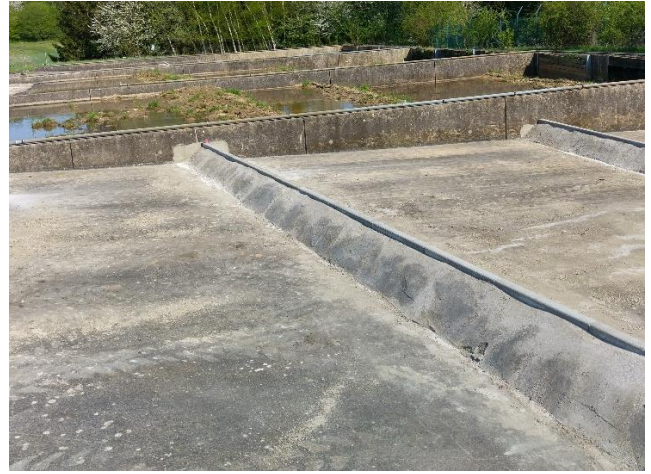
Foto 188: Umbau der zwei randlichen Becken (20.04.2018)
