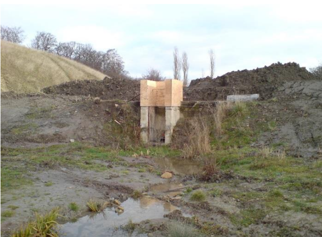
Foto 71: Erhöhung Mönch und Staudamm des oberen Teiches (27.11.2008)
