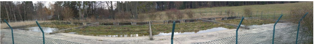
Foto 190: Gefüllte Becken im Folgejahr nach Abschluss der Umbaumaßnahmen (19.02.2019)
