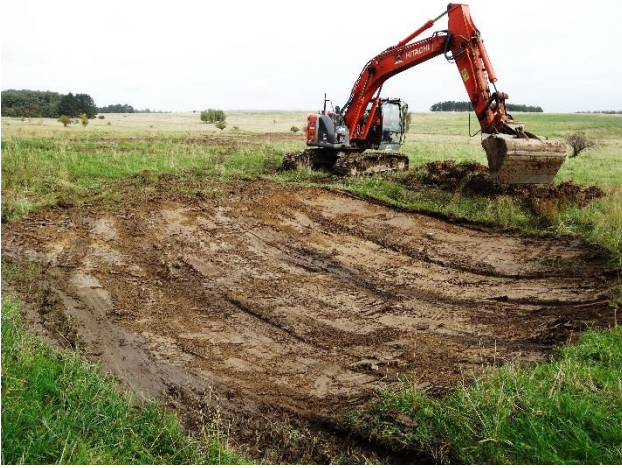
Foto 149: Kleingewässeranlage auf der Langen Dreisch (10.10.2013)
