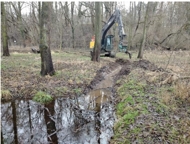
Foto 178: Anlage Bewässerungsrinne oberhalb Grabenstau (03.02.2021)
