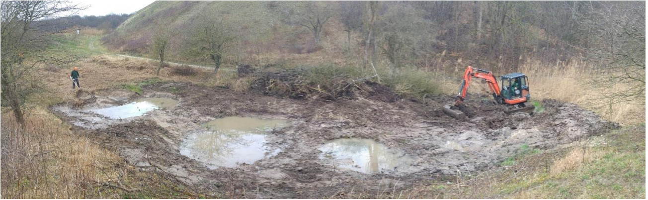
Foto 134: Modellierung Kleingewässer mit Staustufen als „Kaskade“ im Bereich des gerodeten Weidengebüsches (20.02.2020)
