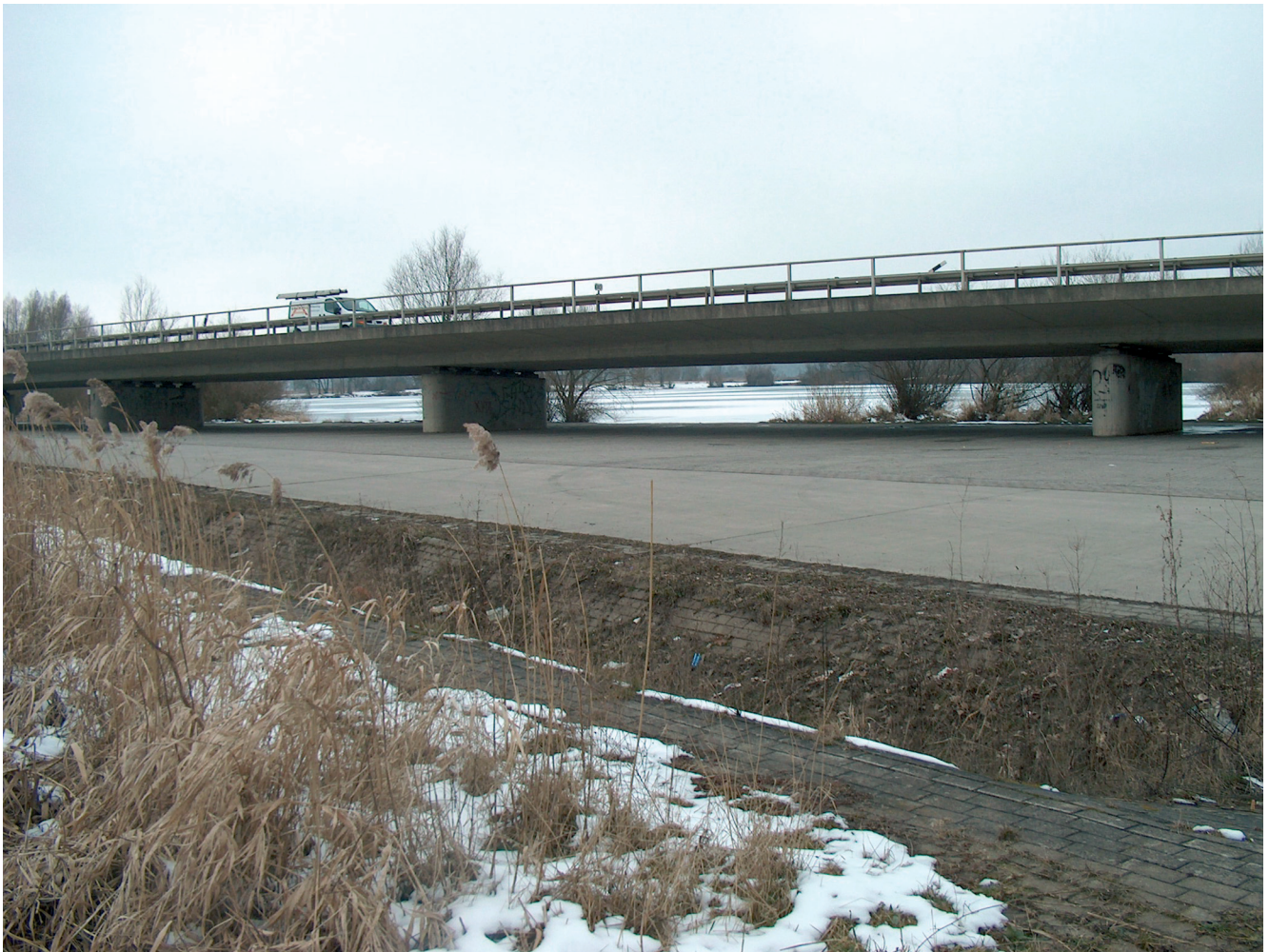
Abb. 35: Aufgeständerte Leinebrücke, Blick in die Flussaue, im Hintergrund Kiesteiche (Foto: A. Böhmert, NLWKN)
