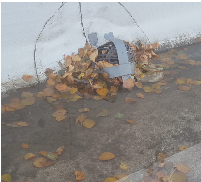
Mynd 13. Hreinsa þarf lauf frá laufgildrum svo að vatn komist óhindrað ofan í regnvatnslögn.
