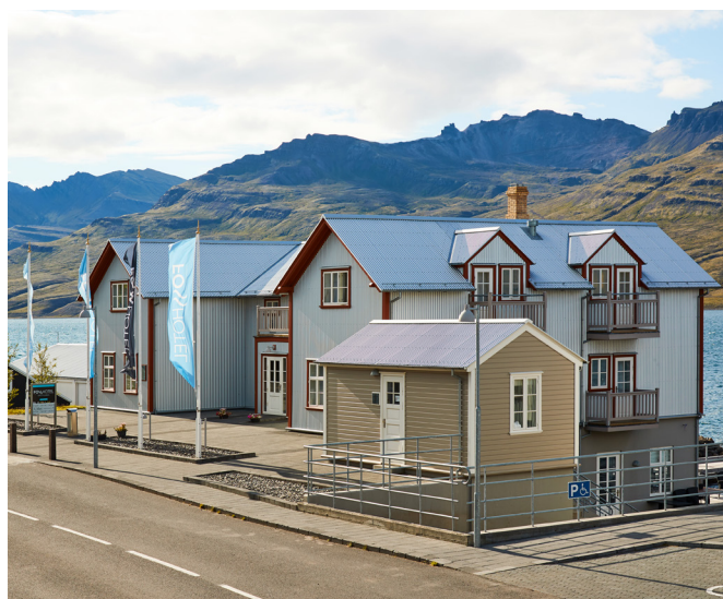
Mynd 27. Kvistir inni á þakfleti ásamt snjóhengjuvörum við þakbrún á Fáskrúðsfirði.
