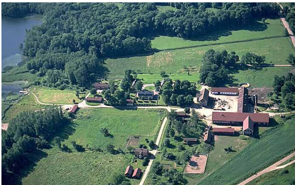
På flygbilden över Kristineholm syns herrgårdens välplanerade omgivning. Ekonomibyggnaderna är avskilda från herrgårdstomten som omges av en parkanläggning. Vägsystemet är rätlinjigt och kantat av ekar.
