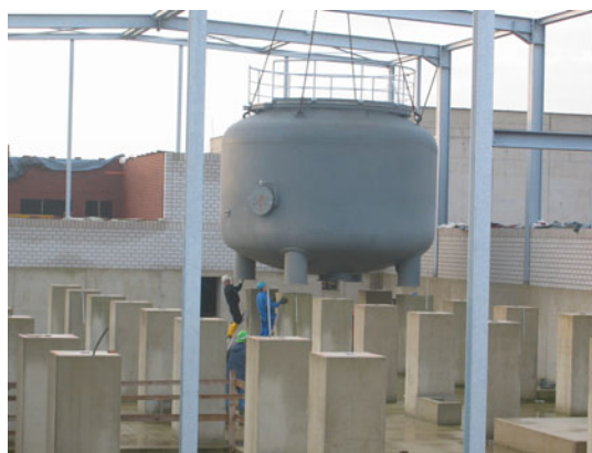
Abb. 32 Einbau der Filterkessel im Wasserwerk Wanlo
