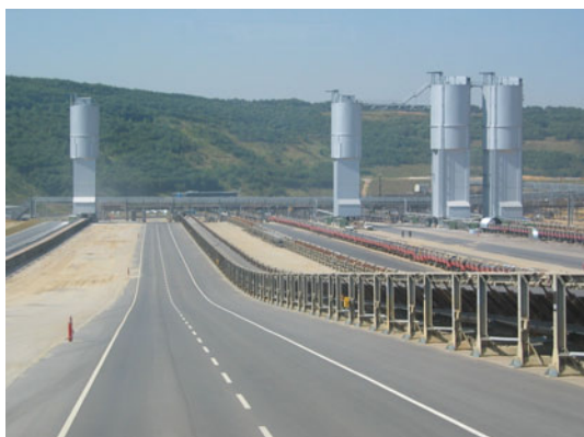
Abb. 16 Kalksilos am neuen Bandsammelpunkt für den Tagebau Garzweiler II
