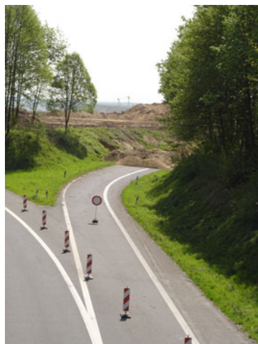
Abb. 12 Abriss der A44: Sperrung im AK Holz
