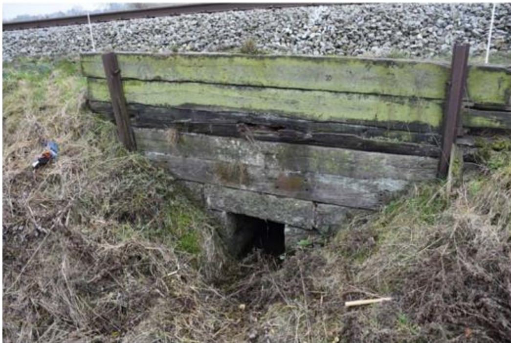
Figur 2: Eksisterende stenkiste ved matrikelnr. 123a, Ullerslev By, Ullerslev
