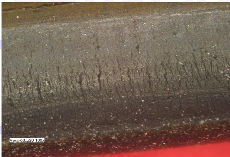
Abb. 22: Risse infolge Alterung durch Wärme und Sauerstoff unter leichter Dehnung an der Anlagefläche eines O-Rings erkennbar
