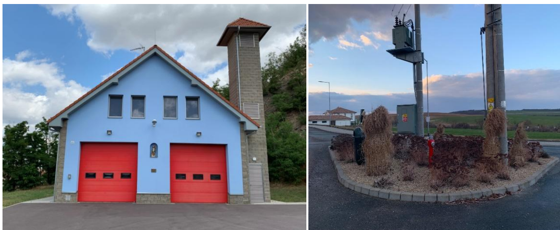
Obrázek 43 Nová budova požární zbrojnice a hasičský hydrant
