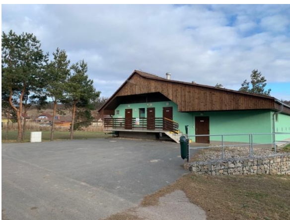
Obrázek 19 Čistírna odpadních vod v obci Únanov
