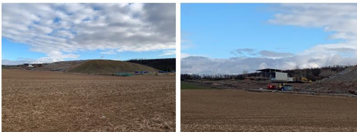
Obrázek 31 Skládka a kompostárna
