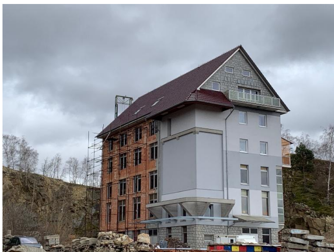
Obrázek 10 Budova rozestavěného mlýna
