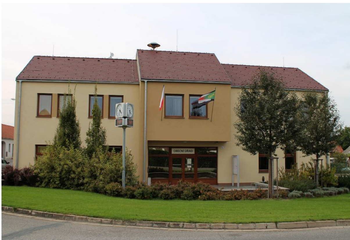
Obrázek 65 Nová budova obecního úřadu s knihovnou v obci Únanov
