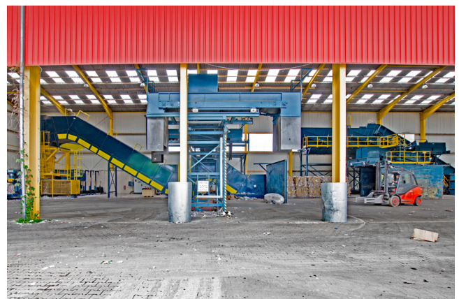
Frontalansicht der automatischen Verladestation vom Außenbereich aus gesehen, Zufahrtswege der LKW.
