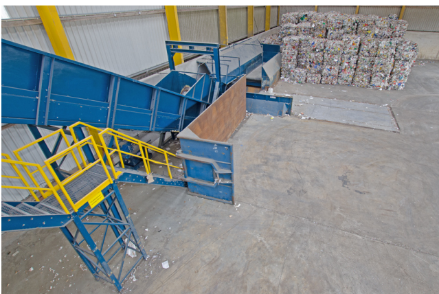
Draufsicht Abkipp-, Lager- und Aufgabebereich mit Schubboden und Aufgabebunker.
