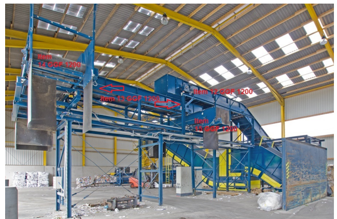
Erstes Verteilerband, Pos. 13 GGF 1200, in Längsrichtung verfahrbar und reversierend, daher Befüllung von hinten nach vorne und umgekehrt möglich.
