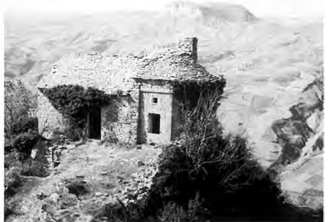
Cailús de La Cressa. (Coll. Arch. dép. A. ; fds. S. E.)
