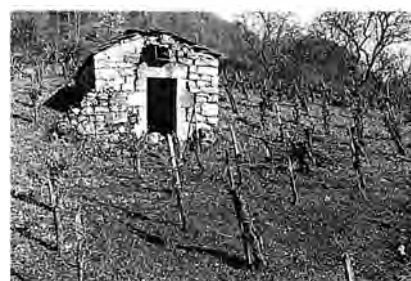
Le toit en lausas des cabanes de vigne permet de recueillir l’eau de pluie pour le sulfatage.
