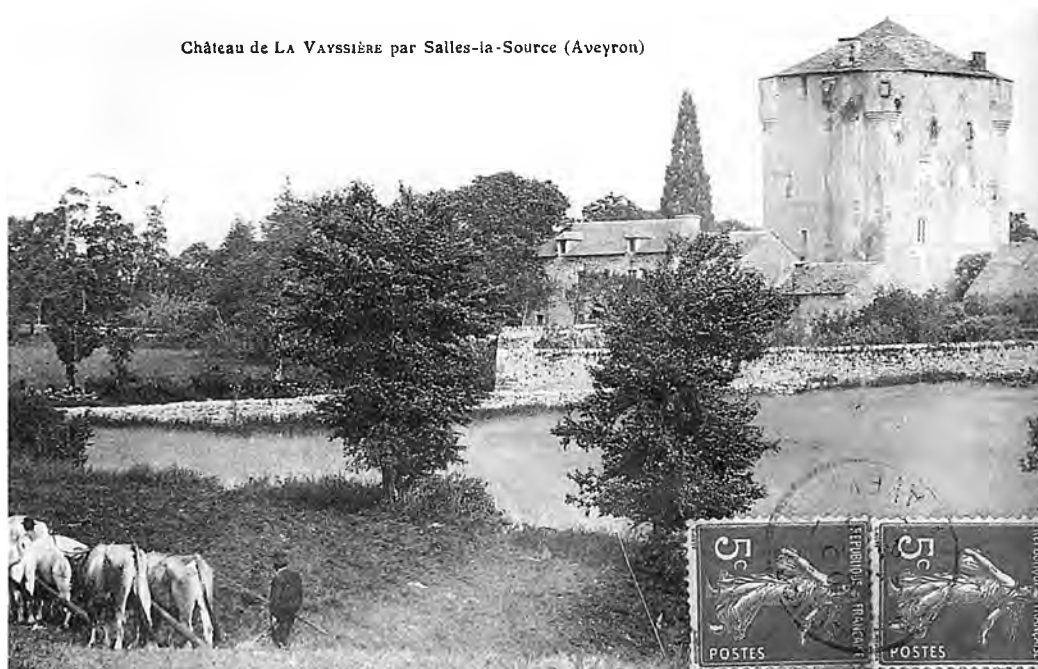
La tour-grenier de la Vayssière
