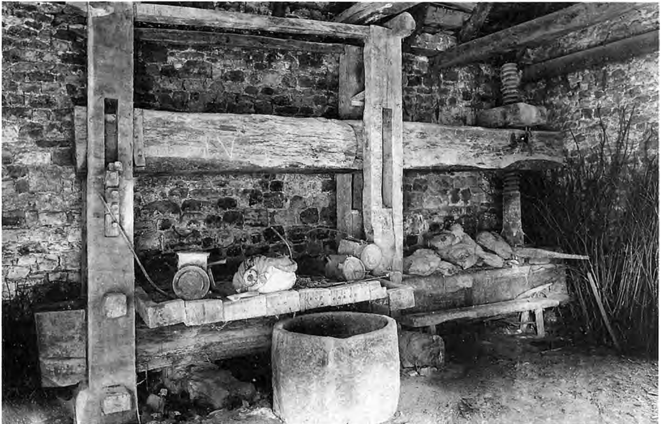
Pressoir à levier et à vis (1841)
