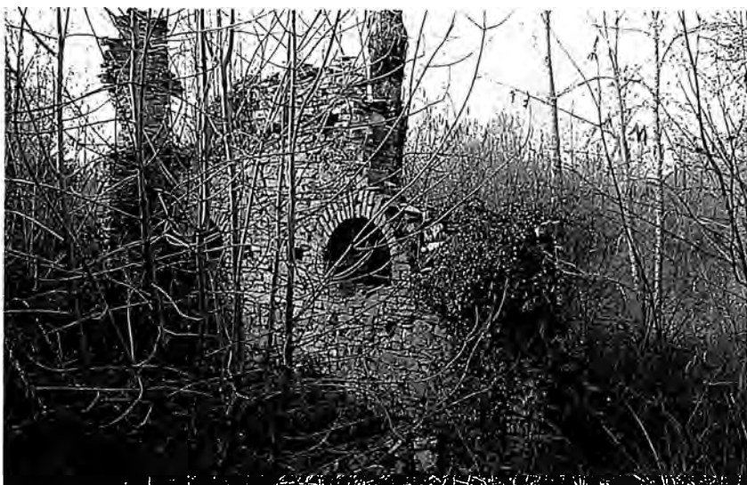
Ce qu'il reste, en 1990, de la gare de Cadayrac
