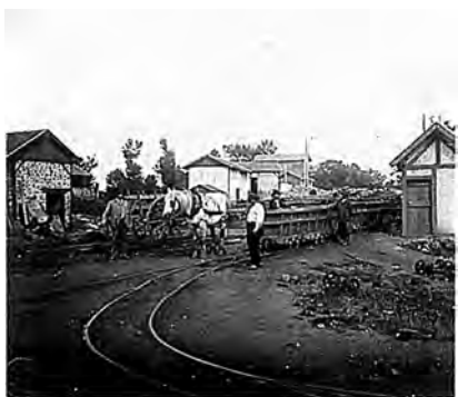
A gauche du cheval, Jean-Pierre Granger, maître mineur à la mine
