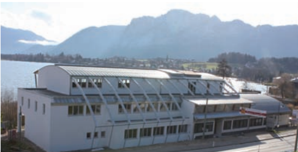
Abb. 1: Der Rohbau des erweiterten Institutsgebäudes am Mondsee (Stand Ende November 2009).
