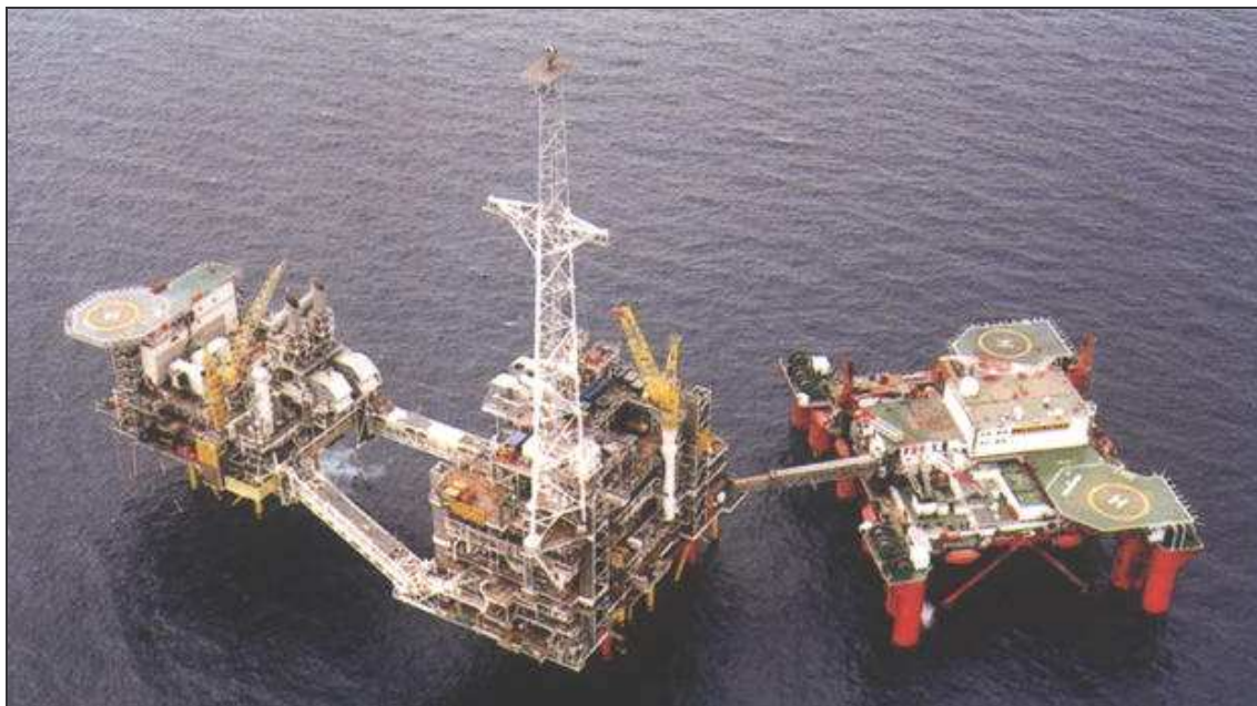
Figur 3.16. Marnock plattformen i britisk sektor. Foto hentet fra: http://www.offshore-technology.com/projects/etaps/etaps7.html
