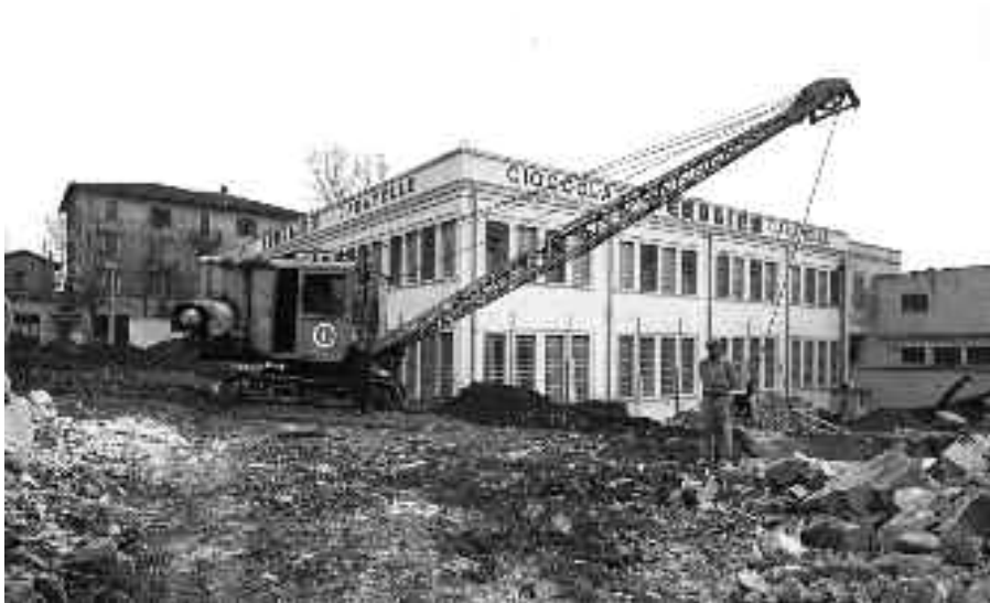
Perugia, cantiere di ampliamento della fabbrica della Perugina, anni Quaranta
