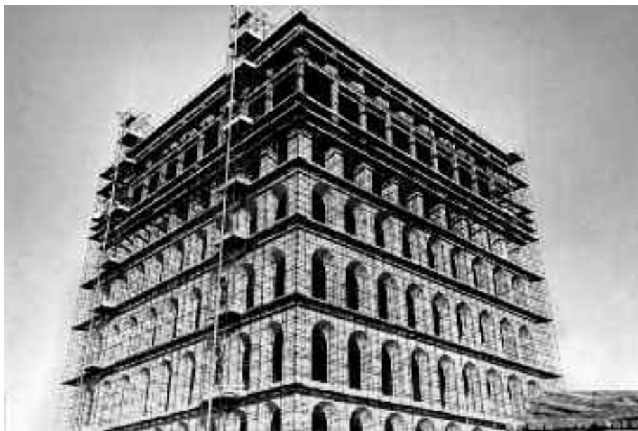
Roma, il Palazzo della Civiltà Italiana in costruzione, novembre 1939
