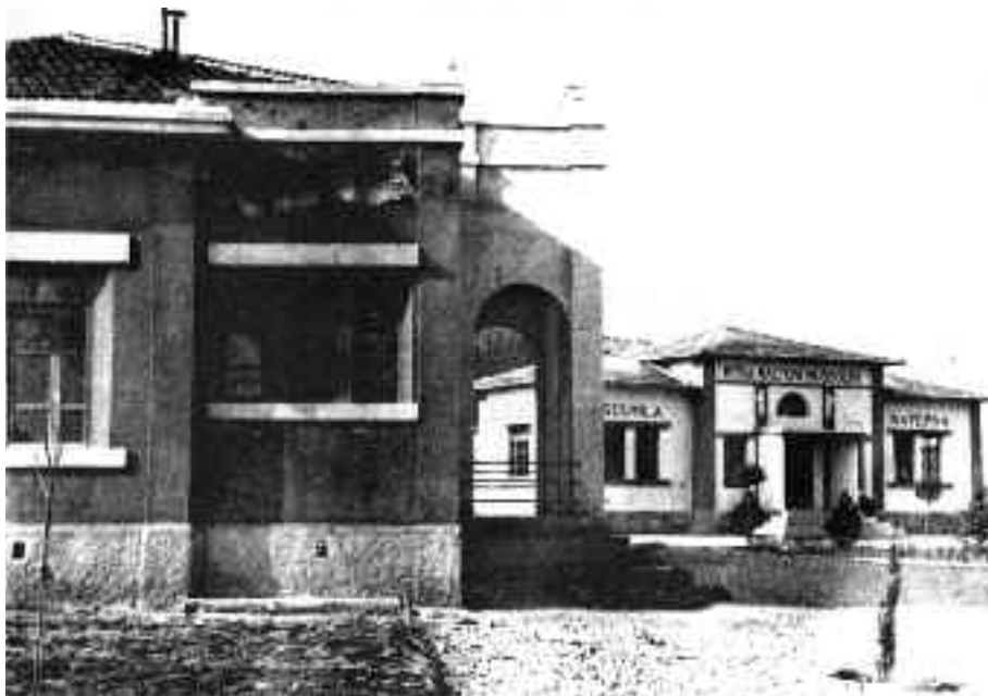
Passaggio di Bettona (Pg), in primo piano la Scuola elementare, 1937; sullo sfondo la Scuola materna "Rosa Maltoni Mussolini", 1939
