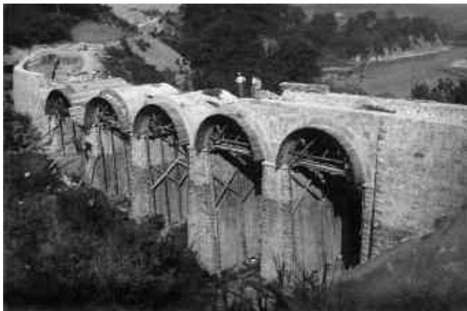
Baschi (Tr), costruzione del ponte sul Tevere, anni Cinquanta
