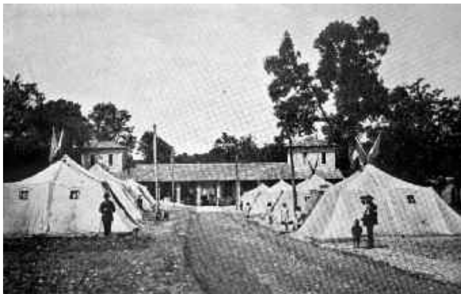
Montelucio di Spoleto (Pg), ex "Colonia del Popolo" già "Sandro Mussolini", 1921-1939, foto d'epoca del prospetto verso monte con le tende dove i bambini dormivano prima della costruzione dei dormitori in muratura
