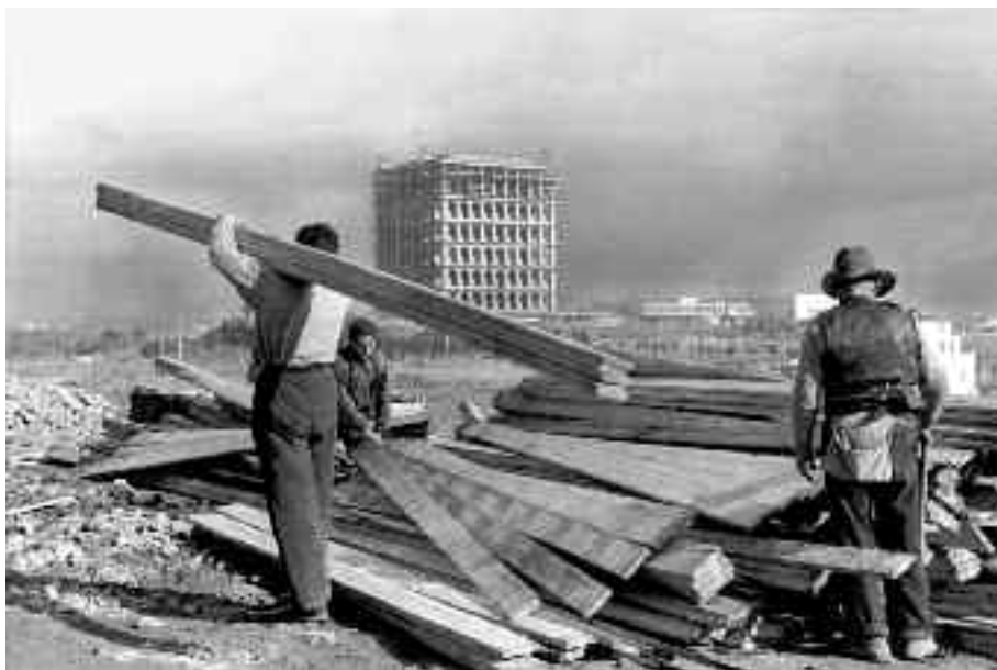
Roma, il cantiere dell'E 42, novembre 1939: carpentieri al lavoro
