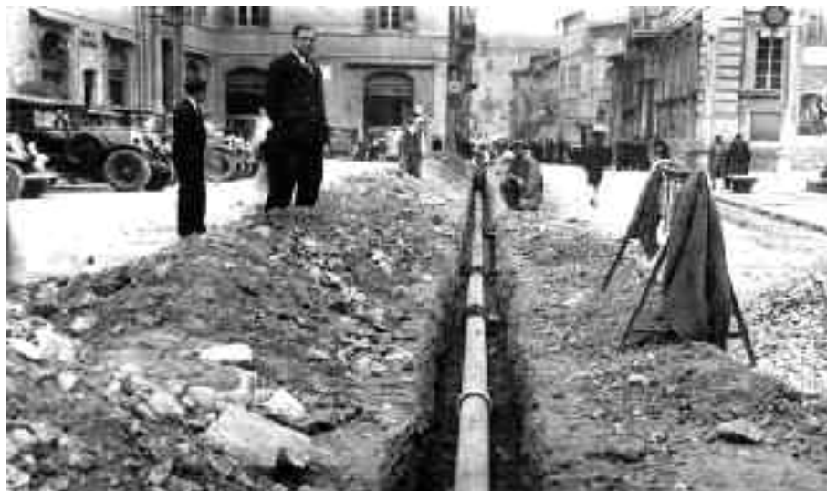
Perugia, lavori per la realizzazione della rete distributiva cittadina, 1932-1936
