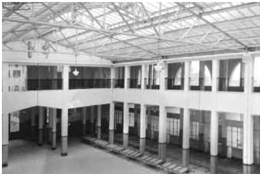
Perugia, Mercato coperto, interno, 1932
