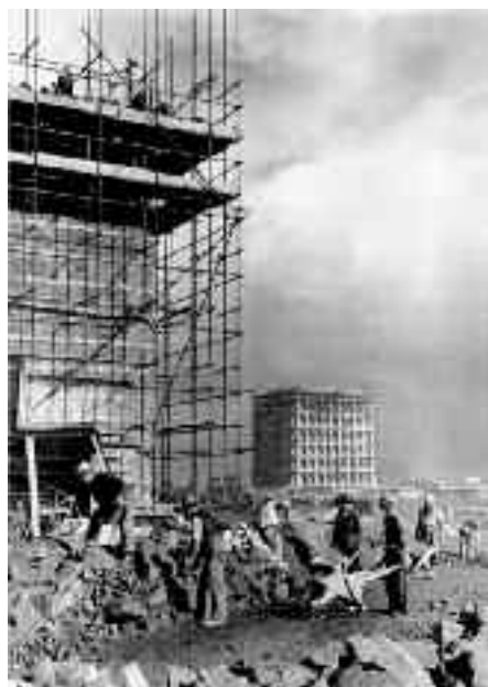
Roma, lavori murari nella chiesa dei SS. Pietro e Paolo, novembre 1939
