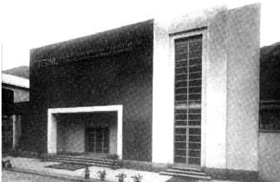
Papigno (Tr), facciata della sede del Dopolavoro Aziendale , 1936 (Archivio fotografico Thyssenkrupp Terni)
