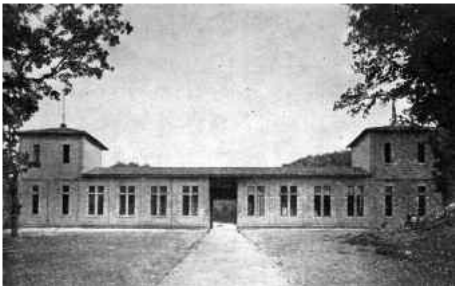
Montelupo di Spoleto (Pg), ex “Colonia del Popolo” già “Sandro Mussolini”, 1921-1939, foto d'epoca del prospetto verso valle del primo edificio realizzato. I padiglioni a monte sono stati costruiti tra il 1933 e il 1939
