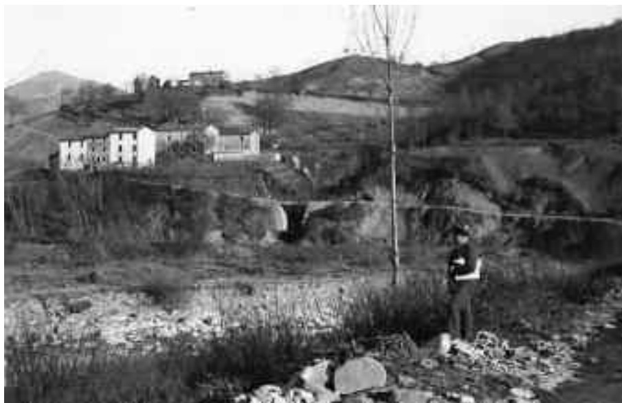
Paesaggio umbro da una foto di cantiere per la costruzione dell'acquedotto di Perugia, 1927-1932
