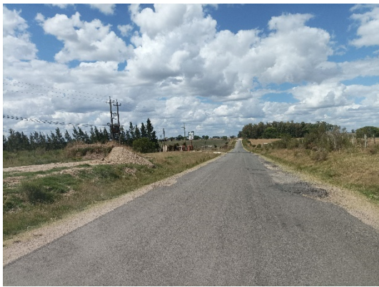
Tramo pavimentado de 500 m desde Raigón
