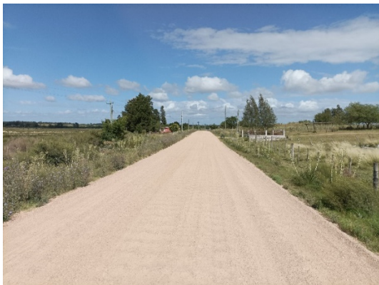
Camino en zona media con vegetación en banquina
