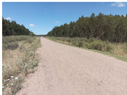
Vista de una sección típica del camino
