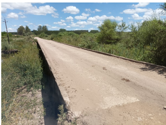
Vista de alcantarilla tipo H en Ao. Grande
