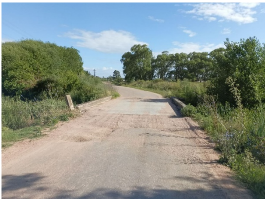
Puente sobre el Ao. Canelón Chico, con relictos de bosque nativo invadido por especies exóticas
