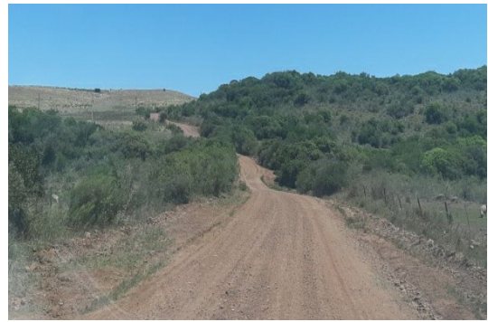
Vista general del camino y zona de curvas
