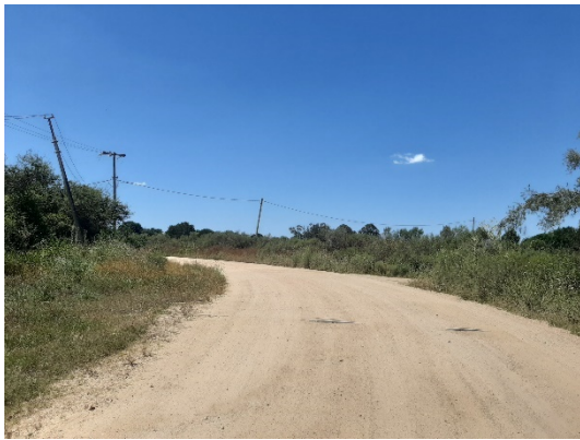
Cruce con vía férrea
