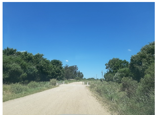
Camino y alcantarilla en Ao. Piedra del Toro
