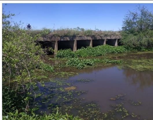
Alcantarilla en Ao. Espinillar
