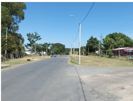
Camino asfaltado, con iluminación y señalización en Paso de la Cruz
