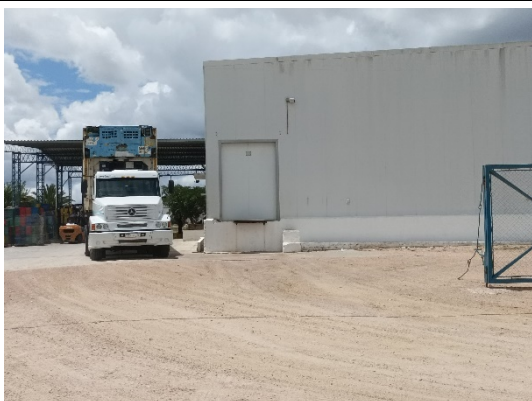
Emprendimiento con cámaras frigoríficas próximo a ruta 36
