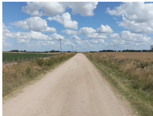
Vista de un tramo característico
