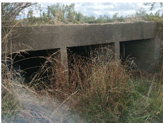
Alcantarilla rectangular de tres bocas
