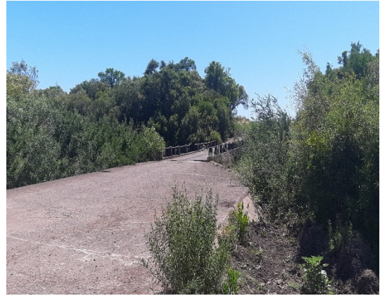
Puente sobre el Ao. Sopas
