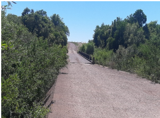
Puente sobre el Ao. Sopas
