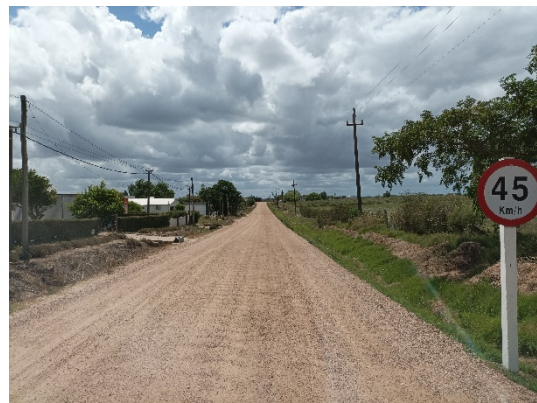
Señalización en zona suburbana Parada Cabrera
