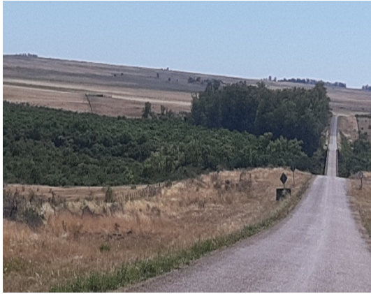
Vista del camino y el puente sobre el Ao. Sopas
