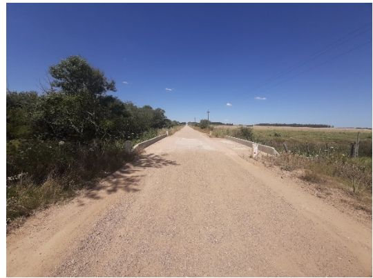
Camino y alcantarilla sobre Ao. Del Cisne
