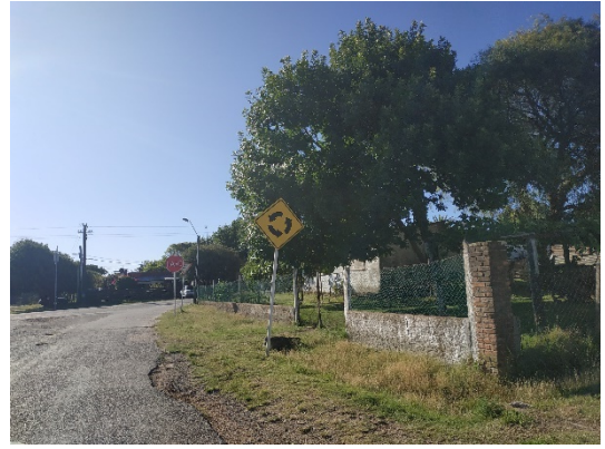
Intersección en Estación Las Flores
