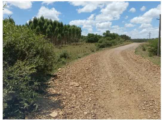
Zonas con recarga de material en cabecera de puente-alcantarilla Ao. Grande
