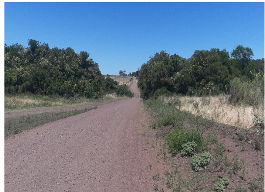
Vista del camino próximo al puente sobre el Ao. Sopas
