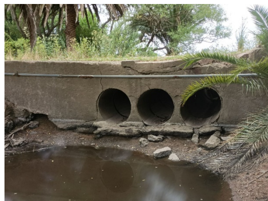
Alcantarilla sobre Ao. De las Brujas Chico
