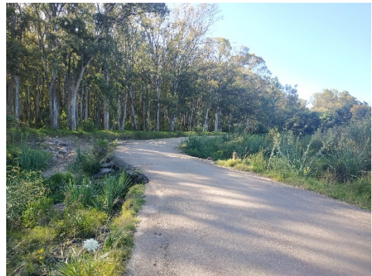
Badén y alcantarilla en Ao. Tarariras
