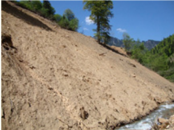
Şekil 5. HES Projelerinde Gelişigüzel Dökülen Hafriyat
