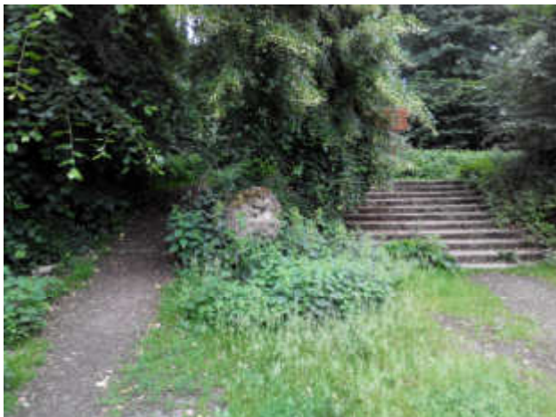
Abb. 149: Denkmalgeschützte Treppenanlage "Unter Kastanien", Foto 2018
