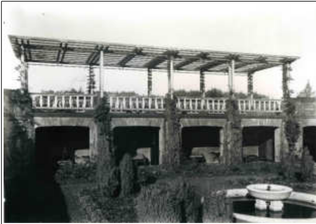
Abb. 60: Terrasse mit Pergola über dem Arkadengang, Foto 1915
