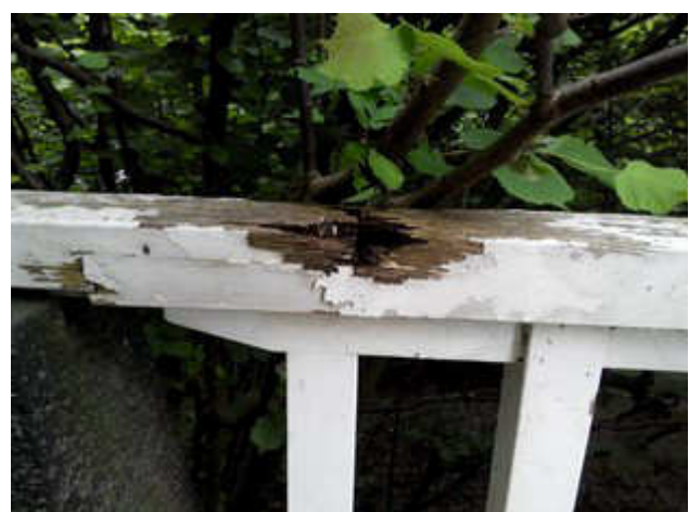
Abb. 38: Zaun am "Stirnband", oberhalb Anger, Foto 2018 Quelle: Weisser, Hohenhof_18-06-05_27.jpg
