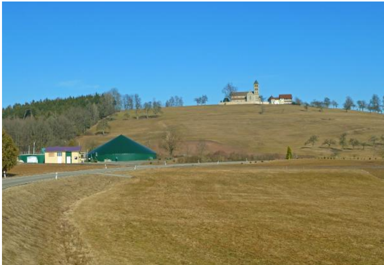
Abb. 13: Biogasanlage vor dem Hohenberg (RVOW 2014)
