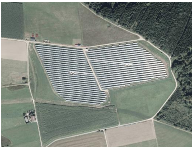
Abb. 12: Freiflächen-Photovoltaikanlage „Deponie Finstere Klinge“ nordöstlich Westhausen mit einer Nennleistung von 6,4 Megawatt 1 (Orthophoto, RIPS-Datenpool 2014)
