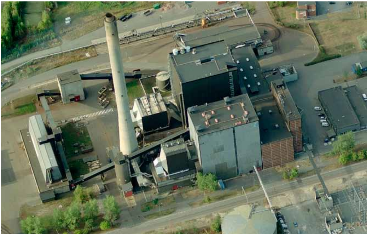
Toppilan voimalaitos tuottaa lämpöä ja sähköä.
