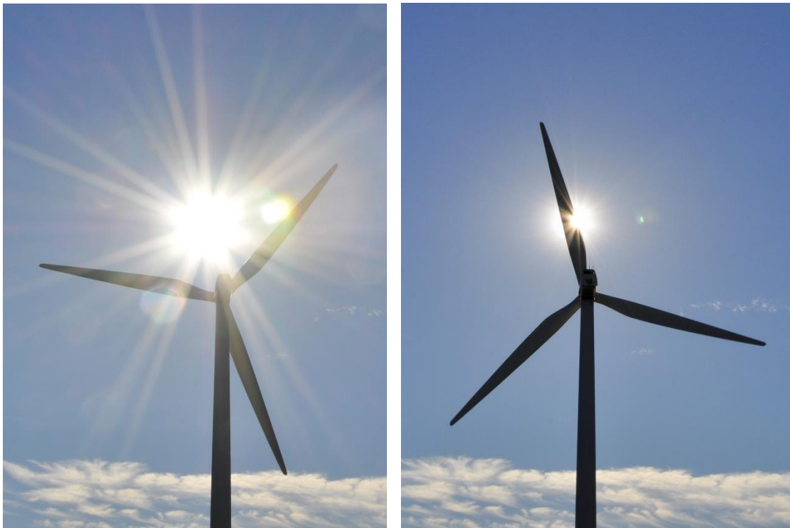
Kuva 7.80. Tuulivoimaloiden lavat aiheuttavat pyöriessään vilkkumista ja varjon välkkymistä aurinkoisella säällä.
