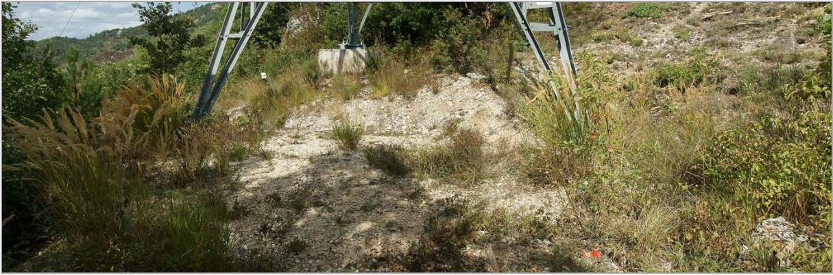
La plateforme du pylône n° 1 de la ligne Castellane – Entrevaux vue en regardant vers le nord (29 septembre 2014).
