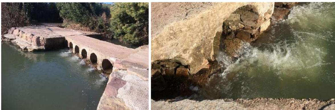
Photos 12 et 13 : Passage à gué du Pas de la Charrette par débits faibles – Vue d'ensemble (à gauche) – Détail d'une chute à l'aval d'une buse (à droite).
