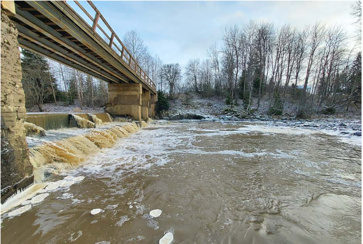
Kuva 5. Rounankosken pato Marttilassa on osa siltarakennetta. KUVA HENNA JUNTUNEN
