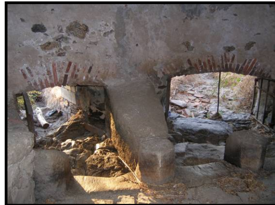
Los cepos en el interior de la Caseta de reparto.
