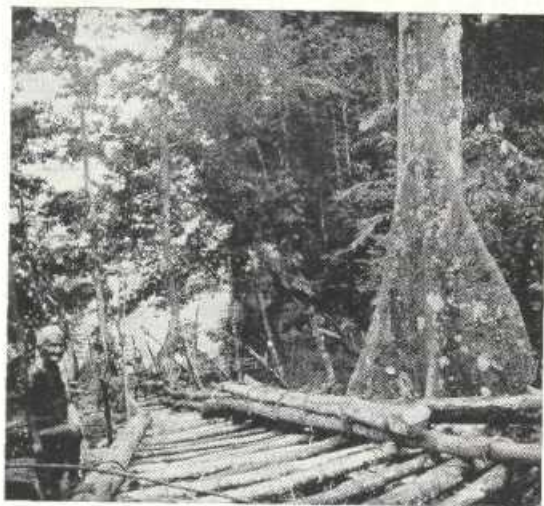
Een knipweg gebouwd door Papoease kappers te Roembati waarlangs de drie ton zware Intsia-balken naar de kust getransporteerd worden. Hier is de helling zo steil dat de balken uit zich zelf met gevaarlijke snelheid omlaag glijden. Meestal moeten de balken langs dergelijke wegen door 30 tot 60 man getrokken worden
