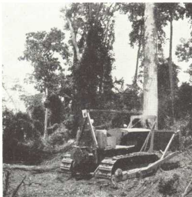
De ondergroei is nu verwijderd en de D 8 gaat beginnen met het graven van een geul rondom de boomvoet, ten einde de zware oppervlaktewortels te verbreken.
