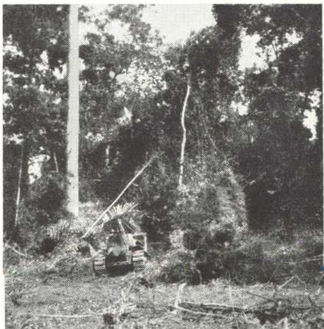
Herzelfde punt van de vorige foto. - Caterpillar D 8 met bulldozer, bezig met het opruimen van de begroeiing rondom de voet van een Amugiusboom (Koordersiodendron pinnatum), welke zal worden omgetrokken.
