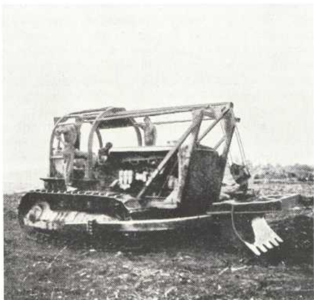
Caterpillar D 8, uitgerust met 5-tandige "stumper", waarboven een vierkante stalen ram is gelast.
