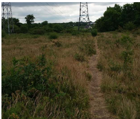
Lande sèche sous ligne haute tension
