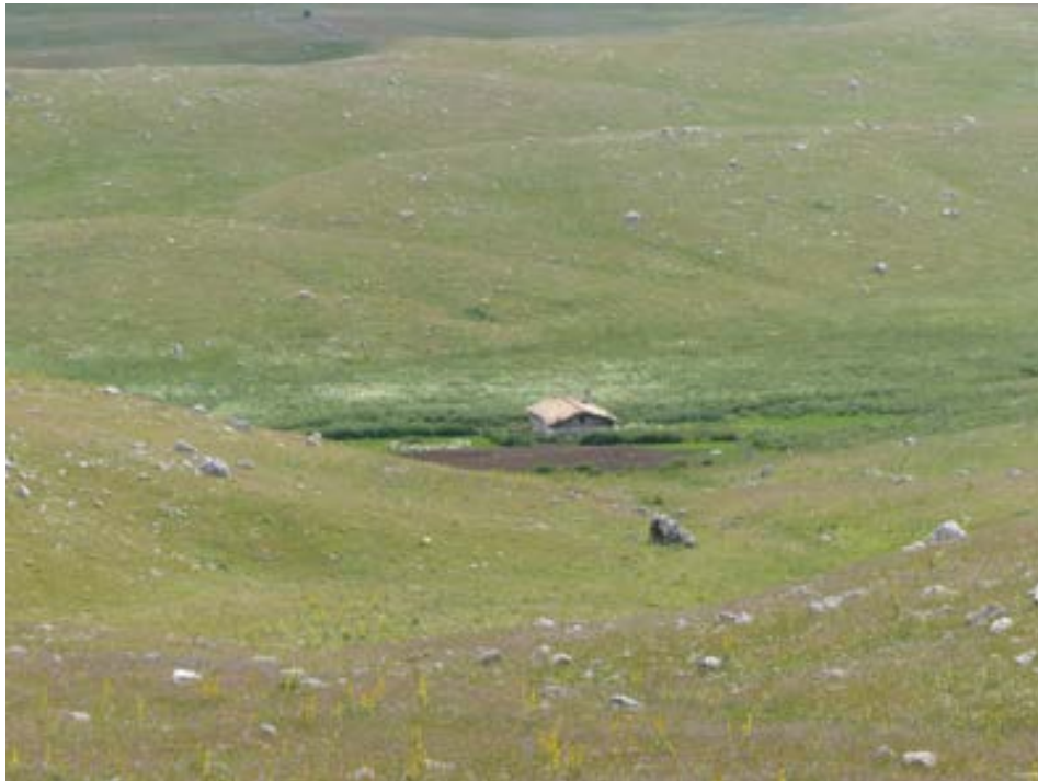
Figura 53: costruzione ad uso zootecnico in precarie condizioni strutturali (Foto B. Ronchi)
