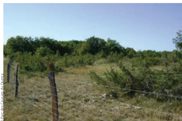
Pose de clôture.
