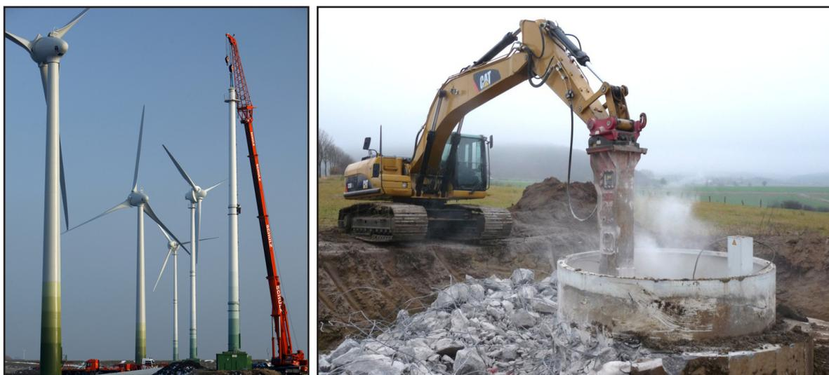
Figure 28: Démantèlement d'une éolienne
